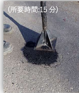
《材料敷均し・転圧》
