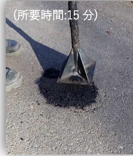
《材料敷均し・転圧》
